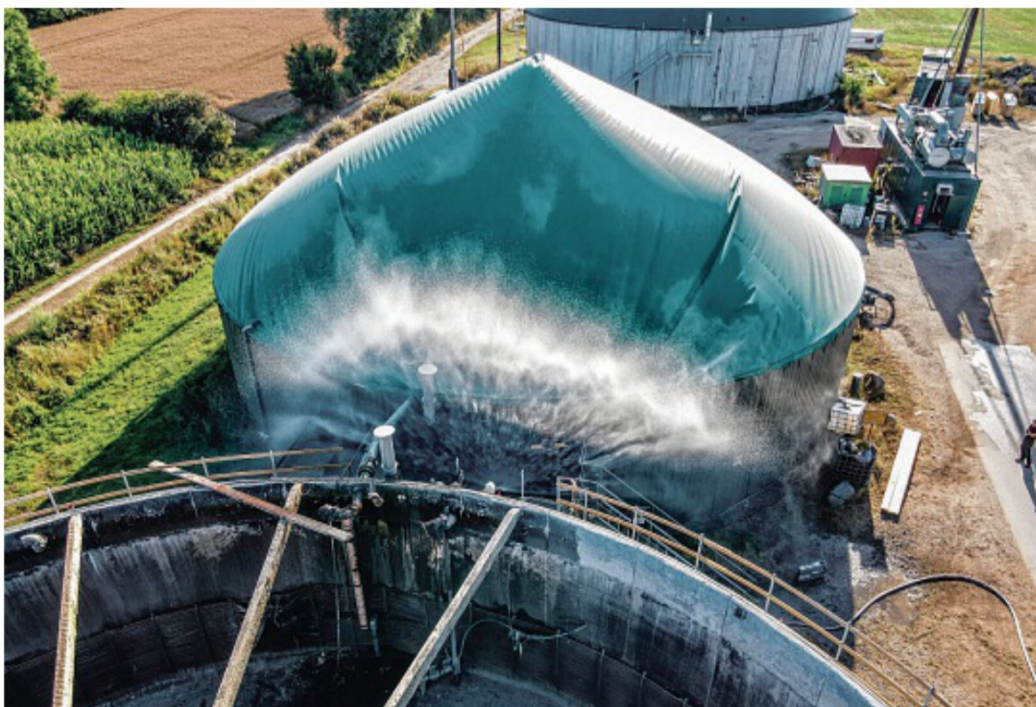
Biogasanlage mit Hydro-Schild im Einsatz.
